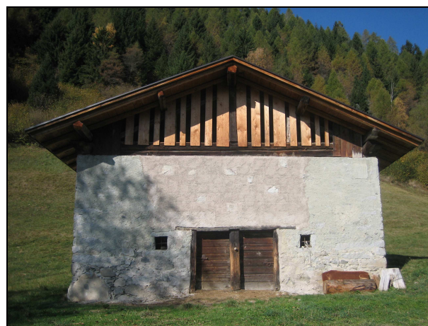
(Edificio rilevato alla scheda n. 18 – loc. Lòdula) Edificio con il colmo della copertura sul fronte principale sostenuto da una capriata
