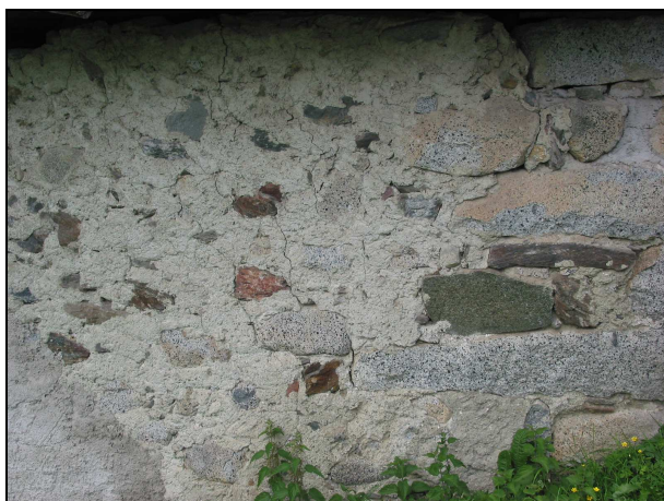
Esempio di intonaco raso sasso
