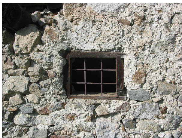
(Edificio rilevato alla scheda n. 65 – loc. Sùia) Particolare inferriata montata su stipiti in legno
