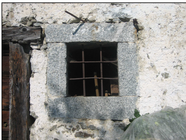
(Edificio rilevato alla scheda n. 91 – loc. Ingiva) Particolare inferriata montata su stipiti in pietra
