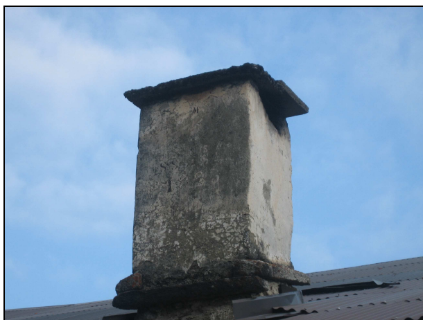
(Edificio rilevato alla scheda n. 87 – loc. Ruina) Particolare camino in muratura
