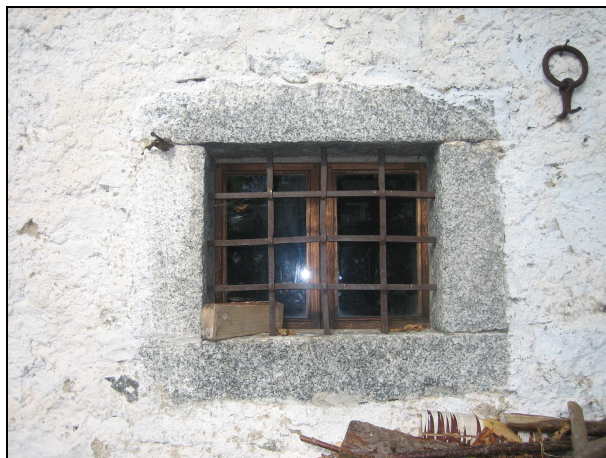
(Edificio rilevato alla scheda n. 68 – loc. Sùia) Particolare inferriata montata su stipiti in legno
