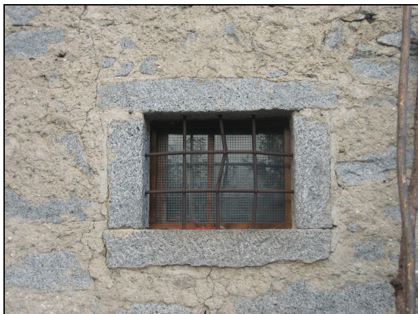
(Edificio rilevato alla scheda n. 87 – loc. Ruina) Particolare inferriata montata su stipiti in pietra
