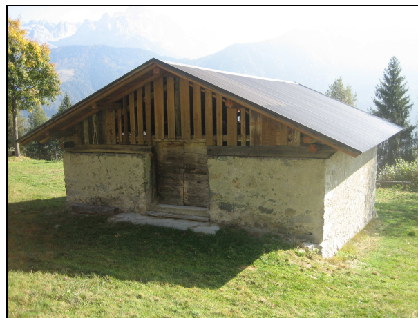
(Edificio rilevato alla scheda n. 18 – loc. Lòdula) Edificio con il colmo della copertura sul retro sostenuto da una capriata
