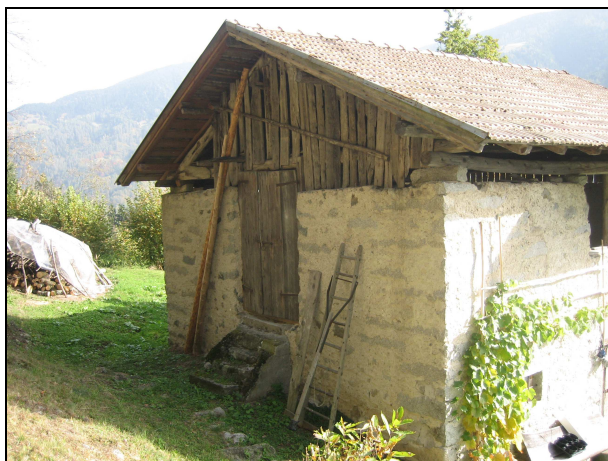
(Edificio rilevato alla scheda n. 4 – loc. Pomasèra) Edificio con il colmo della copertura sul retro sostenuto da una capriata
